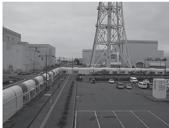
柏崎刈羽原子力発電所（新潟県）【提供者：原子力資料情報室】
